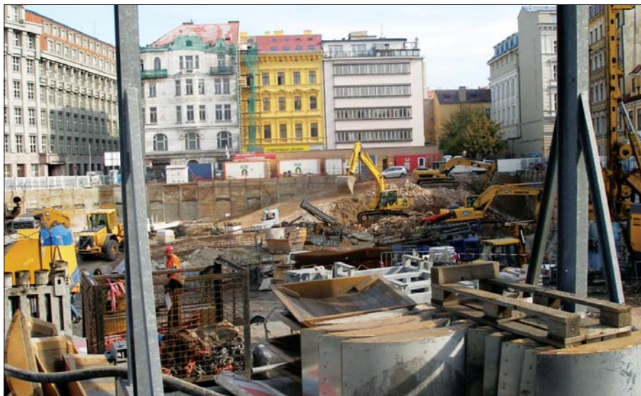
I ve složitých podmínkách výstavby se loni nezapomínalo na BOZP.
